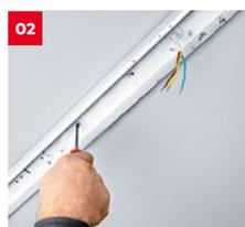
02 Faites passer le câble d'alimentation par l'entrée de câble, fixez le corps du luminaire sur la surface de montage
