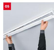
05 Fermez le luminaire en refixant le diffuseur sur le corps
